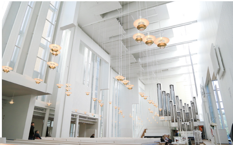
ユハ自身が設計したペンダント。光源が隠れており、眩しさを感じない設計となっている。教会内では長いワイヤに吊るされ、4つで1グループとなり空間にランダム配置されていた。
